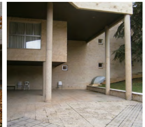
68. Acceso lateral a sótano P-2
