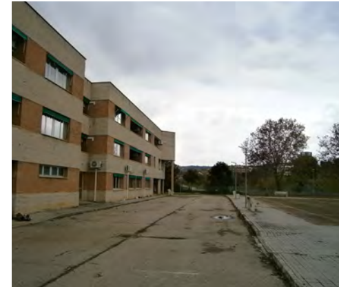
50. Fachada sureste y cancha
