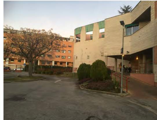
71. Acceso principal al edificio
