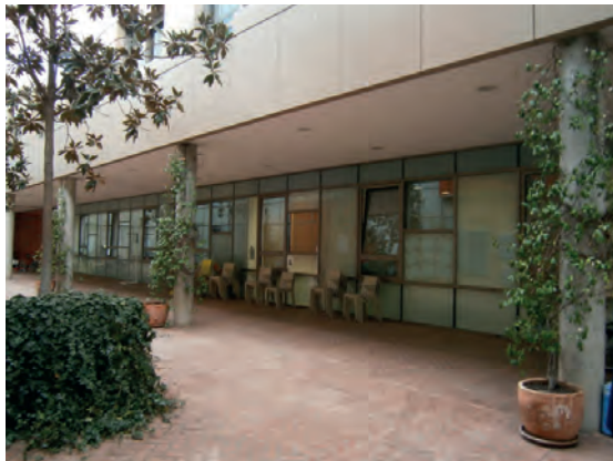
53. Patio principal interior cubierto
