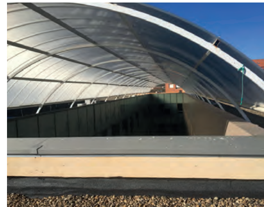
Cubierta patio interior principal
