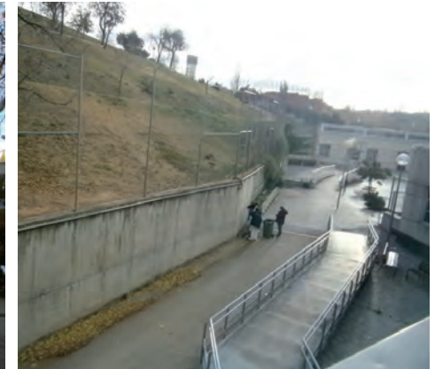
77. Rampa de acceso lateral
