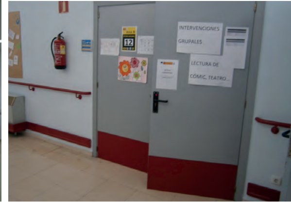
26. Puerta de acceso a aula
